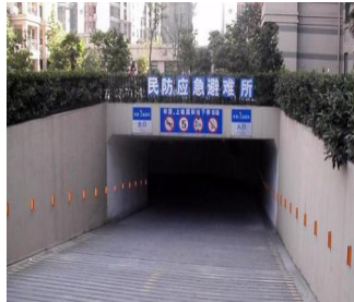
人防地下室监控
