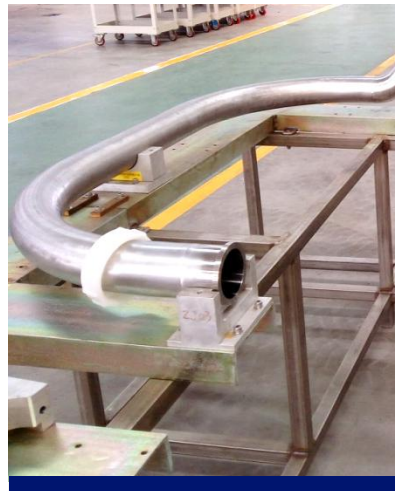
不锈钢主管道
