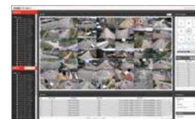
CCTV综合监控屏幕控制
